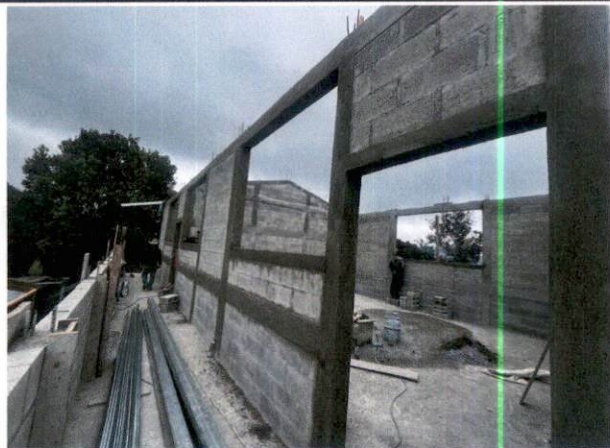
Foto1: Finalización de levantado de muro
