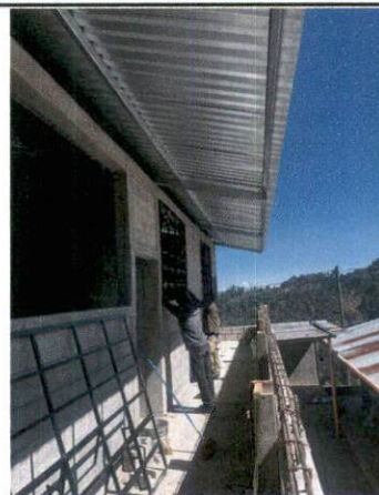
Foto 4: colocación de ventanas y puertas
