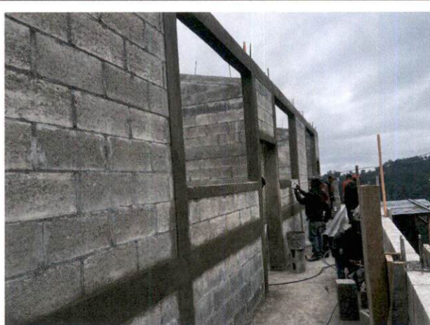
Foto 2: Tallado de estructura
